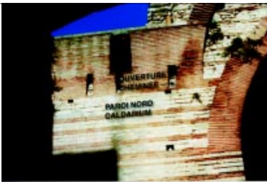
Figure 15. The junction between the roofing and flue apertures in the north-west angle of the caldarium: current state. [La jonction entre couverture et ouverture de cheminée dans l'angle Nord-Ouest du caldarium: état actuel.]
