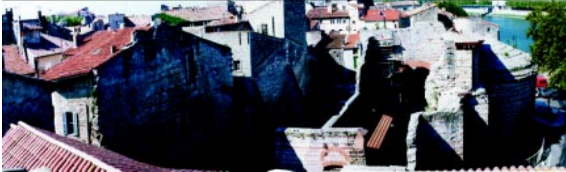
Figure 3. View from northwest of the Thermae of Constantin. [Vue d'ensemble sur les Thermes de Constantin depuis le Nord-Ouest.]
