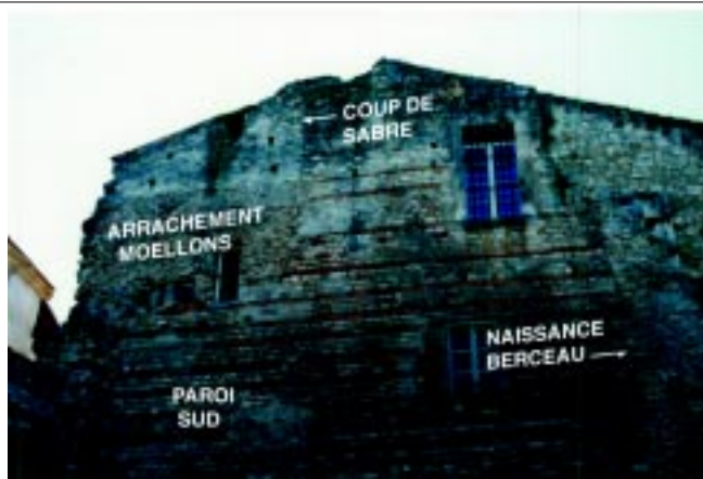
Figure 8. The visible traces on the laconicum south wall of the Thermae of Constantin. [Les traces visibles sur la paroi Sud du laconicum des Thermes de Constantin.]
