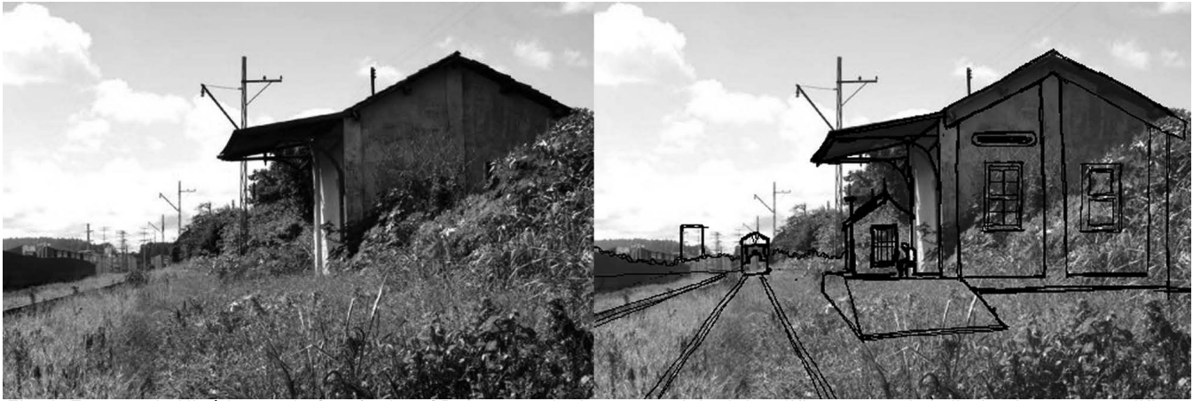
Fig. 1. Estação do Hipódromo de São Carlos, SP. A esquerda, imagem original da edificação atual. A direita, imagem modificada com o auxílio da tablet desenvolvida pela pesquisadora. Foto original de Bê Caviquioli (2008).
