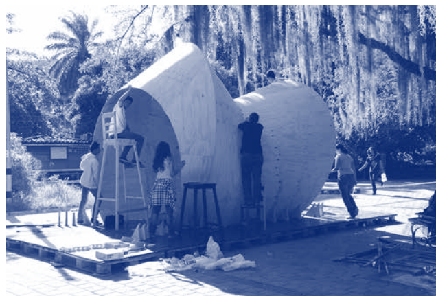
Figura 5: Fase final de montaje del pabellón The Cocoon. Campus Unal Medellín.
