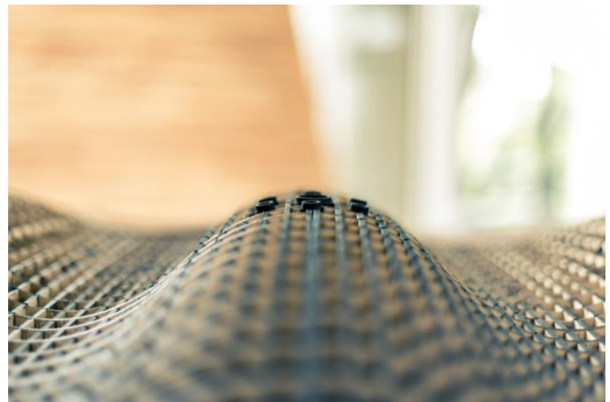
Figura 6: Lucernarios de la cubierta.
