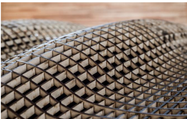
Figura 5: Cubierta por encastre (detalle).
