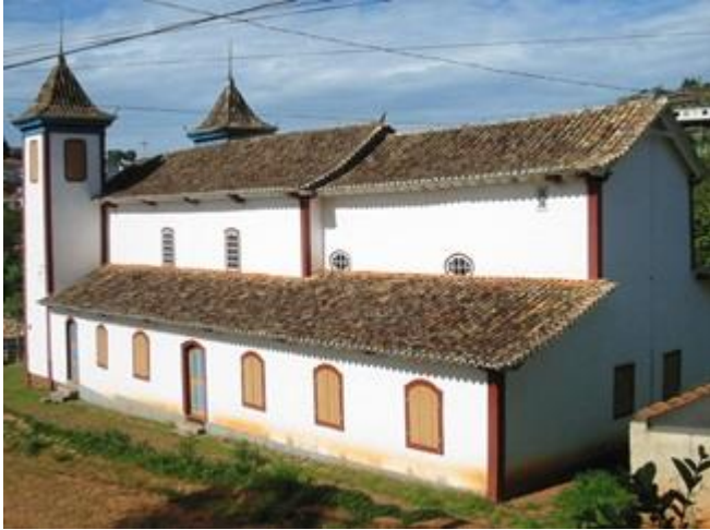
Figura 2: Fachada lateral direita da Igreja Bom Jesus do Matozinhos. Fonte: Teixeira (2003)
