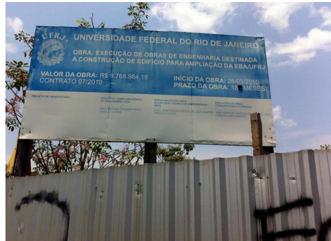
Figura 5: Placa da obra, onde é possível ver data de início e prazo (vencido). Acervo próprio.
