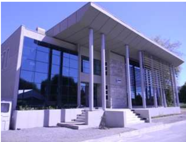
Figura 2: Edificio caso de estudio: CITEC UBB ( www.citecubb.cl )
